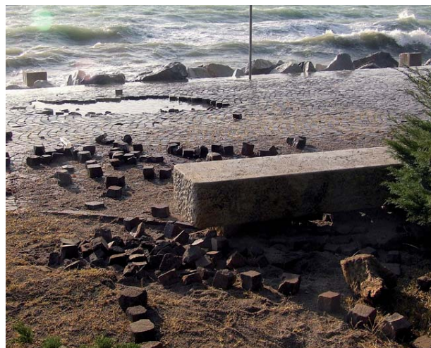
La mareggiata provoca vari danni in particolare alla massicciata in pavè della passeggiata a mare
