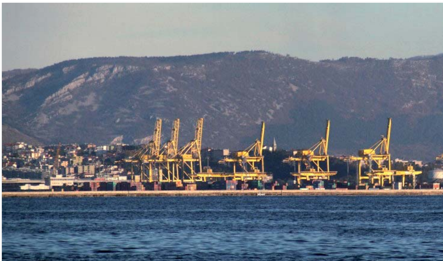
Una panoramica della zona portuale di Trieste vista dal Golfo di Trieste. A destra è visibile il complesso industriale siderurgico "Ferriera" di Servola
